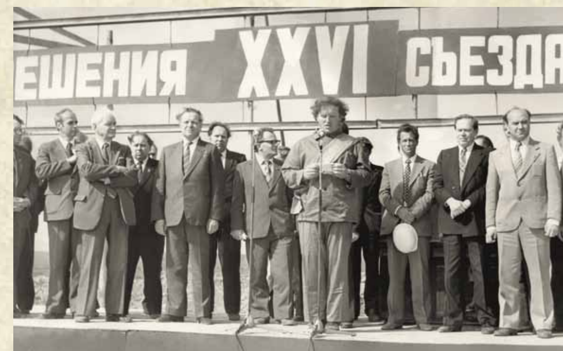
2 июля 1981 г. – митинг на строительной площадке «Торская» в честь закладки первого куба бетона
