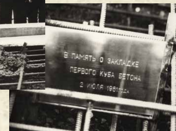
Впереди еще 2 млн 500 тысяч кубометров бетона. ... И 30 ЛЕТ РАБОТЫ!!!
