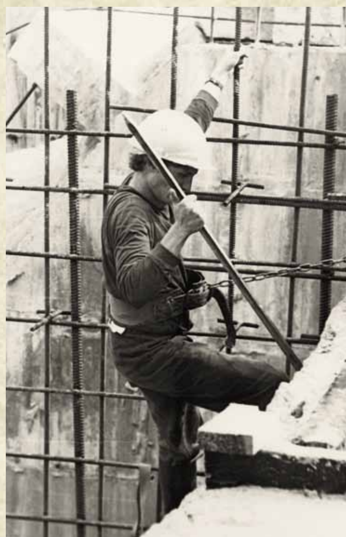
Подготовка блока к бетонированию. Петя Хеймонен
