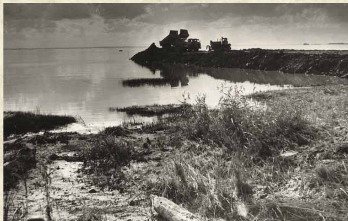
Первые метры отсыпки дамбы Д-11. Впереди еще свыше 36 млн 700 тысяч кубометров грунта
