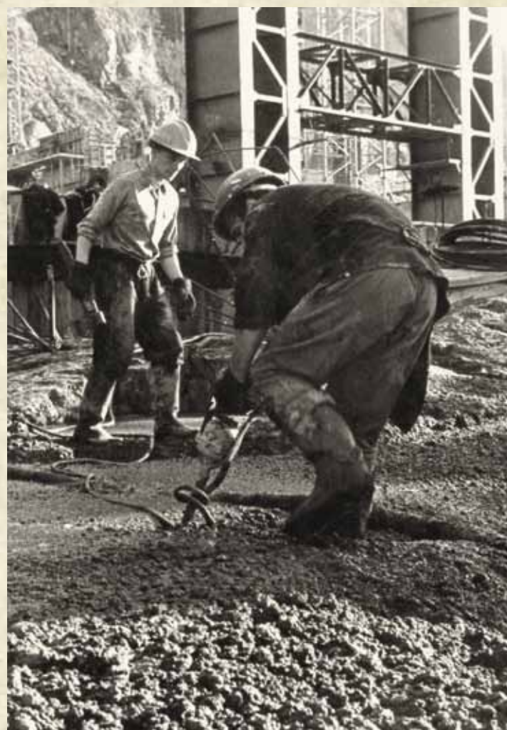
Уплотнение бетона вибратором. Это еще не те «вибраторы»
