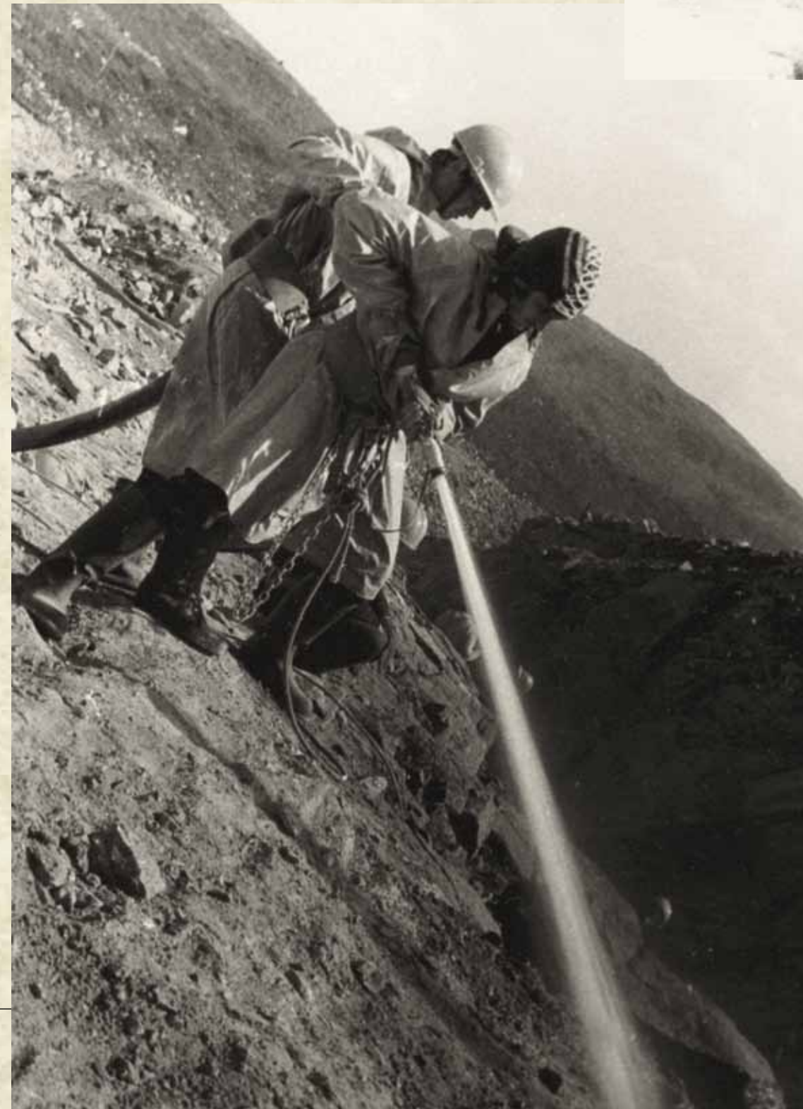
Промывка скалы Подготовка основания к бетонированию
