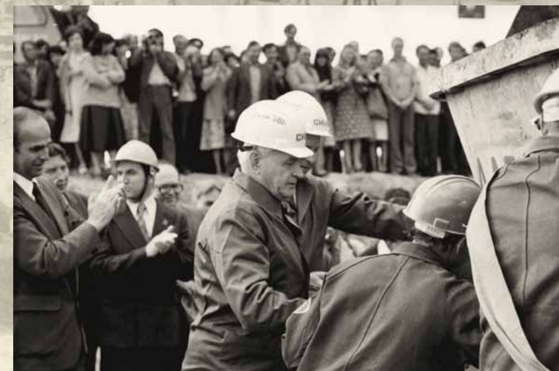
2 июля 1981 г. – министр энергетики СССР Непорожний П. С. участвует в укладке первого куба бетона в водопрпускное сооружение В-6
