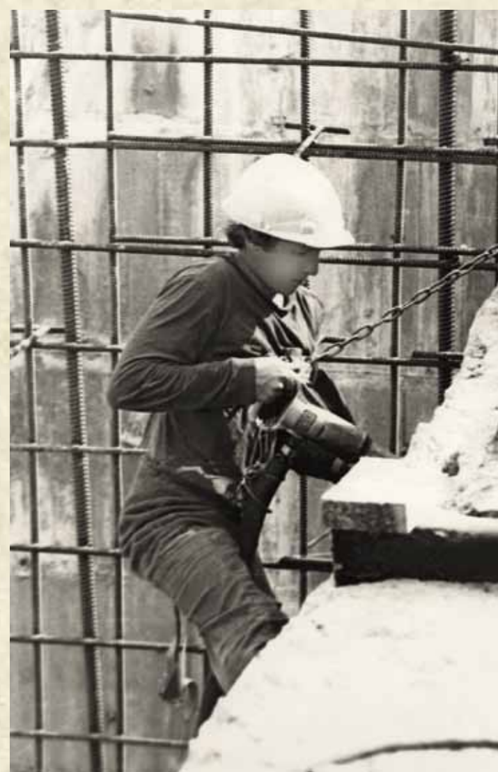
Подготовка блока к бетонированию. Петя Хеймонен
