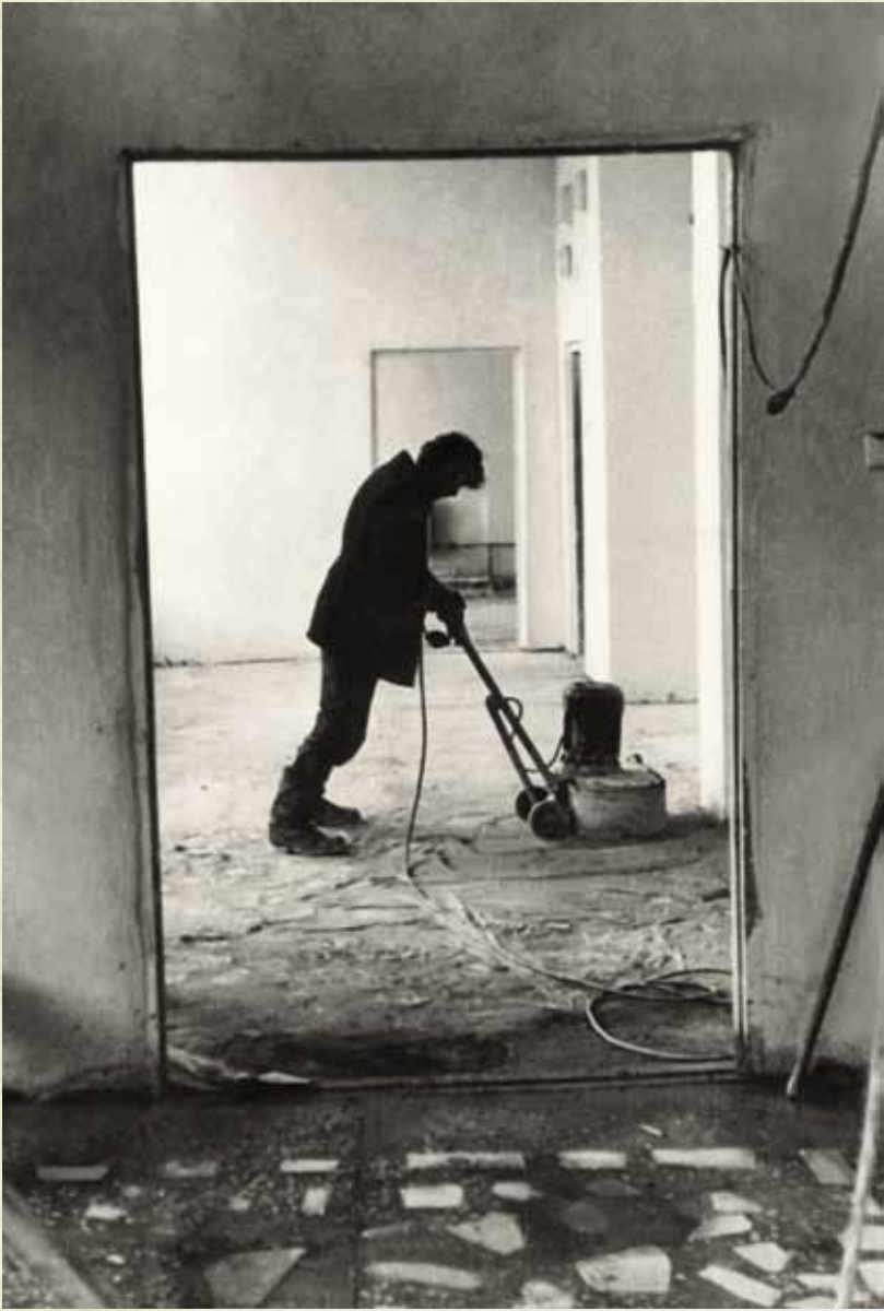
Устройство мраморных полов на погте города Княж-Погост Турганбай Мурзамуратов
