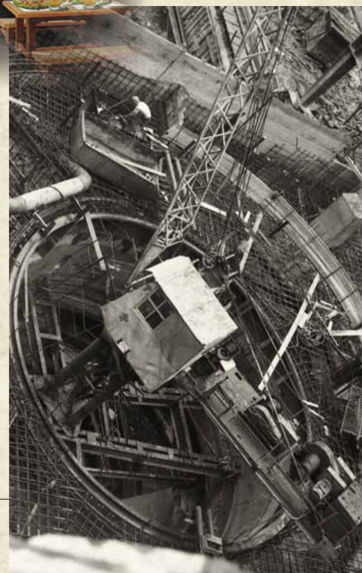
Спиральная камера агрегата №3
