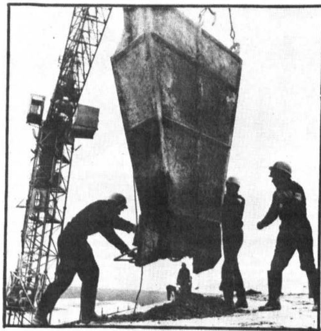
Хорошо работают бойцы студенческого строительного отряда «Солнечный» Электротехнического института. Они участвуют в возведении нового цеха завода керамических плиток в селе Никольском Ленинградской области. На снимке: идет прием бетона.
