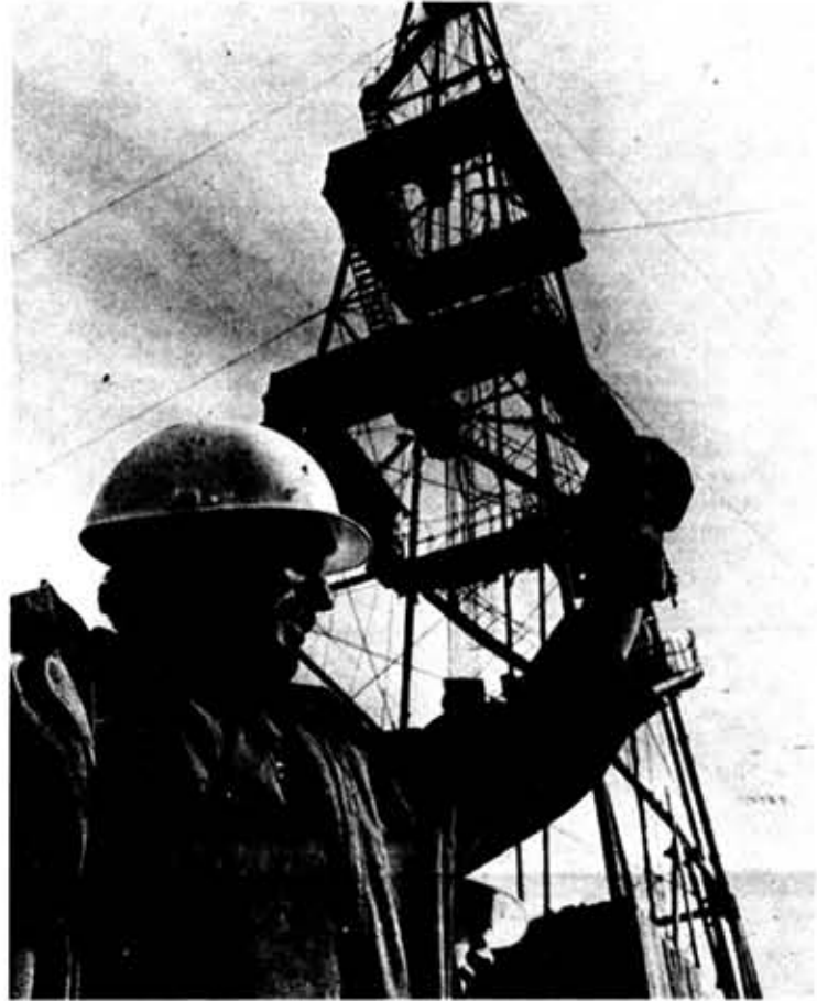
Отряд «Молодость» Института авиационного приборостроения вот уже три года работает на обустройстве сваями Возейского месторождения в республике Коми.
