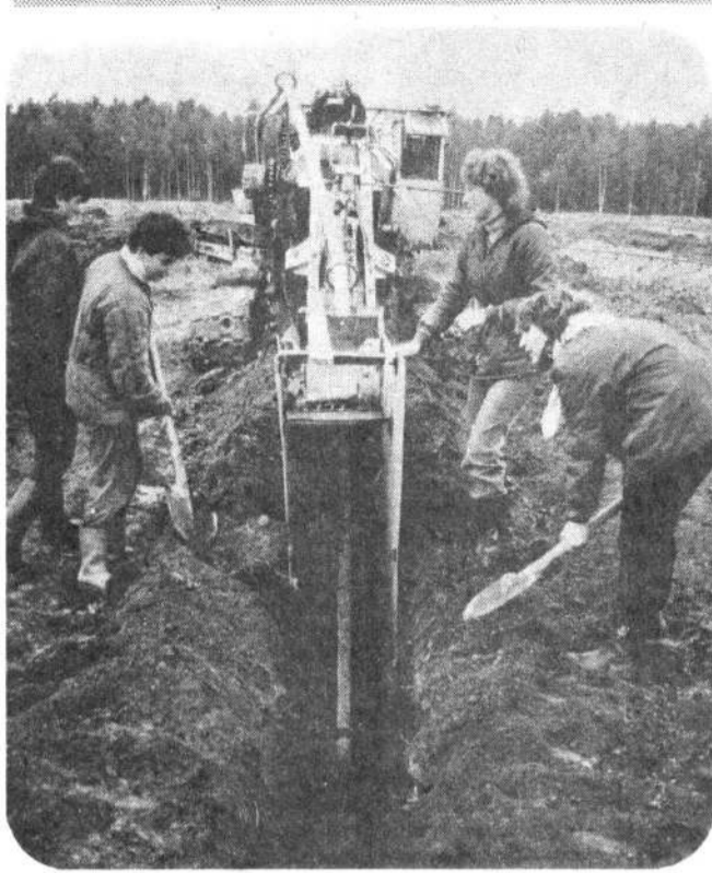
Бойцы отряда «Энтузиаст» Института водного транспорта помогают мелнораторам давать «вторую жизнь» полям совхозов Кингисеппского района. На снимке А. Владимиров вы видите, как одна из бригад отряда готовится к укладке дренажа.
