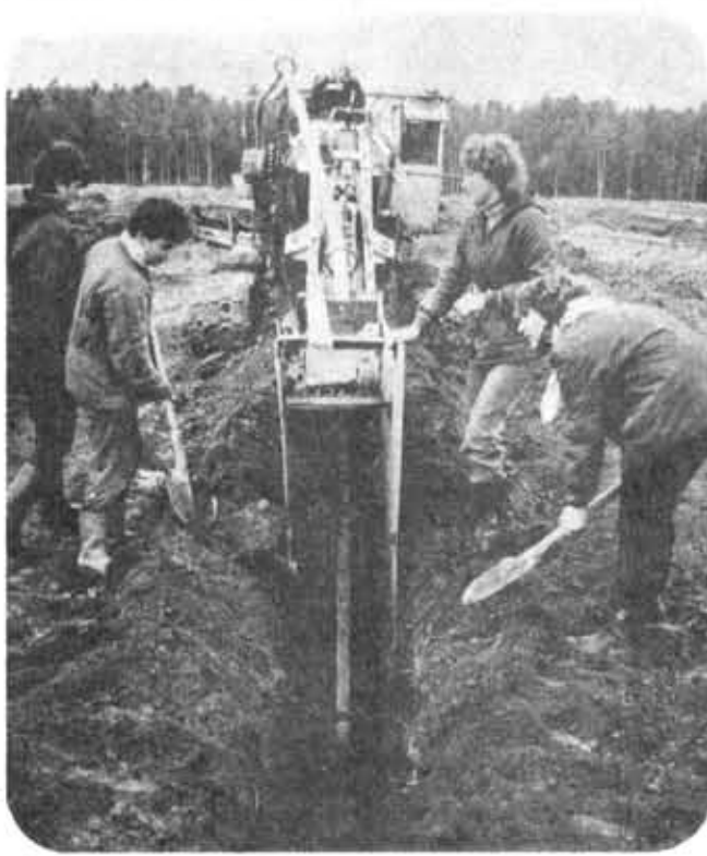
Бойцы отряда «Энтузиаст» Института водного транспорта помогают мелнораторам давать «вторую жизнь» полям совхозов Кингисеппского района. На снимке А. Владимиров вы видите, как одна из бригад отряда готовится к укладке дренажа.
