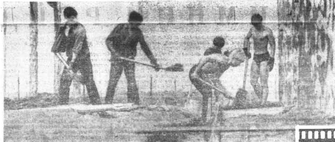
Экстерьер будущего коровника пока еще обозначен деревянными столбами-стойками, но бетонировать полы можно уже сейчас. Бригаду Виктора Авзана не остановить — идет бетон.
