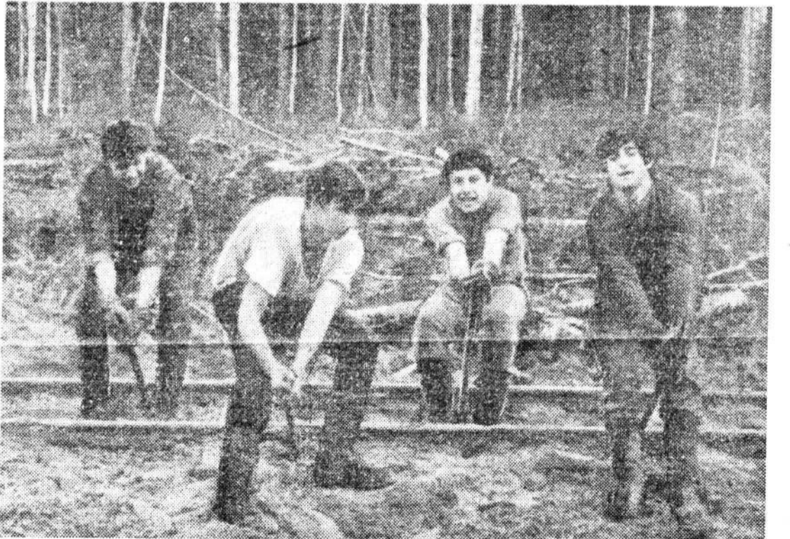
— Раз-два, взяли... — в такт раскачиванию командует Миша Райхельсон (впереди справа). Так начинается рихтовка узкой колес.
