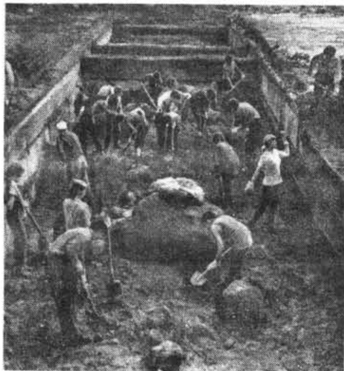
Пятьдесят бойцов отряда «Фортун» Приозерского района строят дом в поселке Минчуринское.
