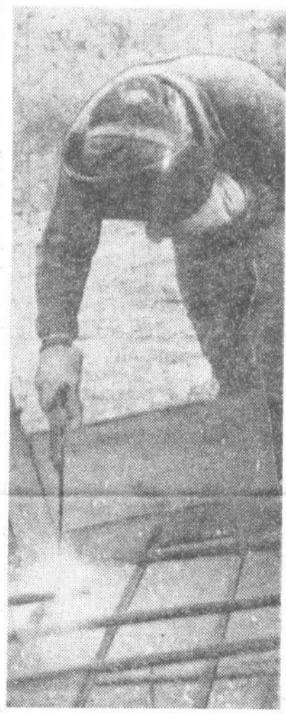
Легкий удар по стальному стерж- ню, и вспыхивает дуга электросвар- ки. Это Игорь Валезнович из «Спар- ты» (ЛТИЦБП) работает на монтаже арматуры железобетонных конструк- ций.
