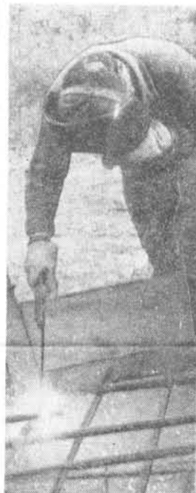
Легкий удар по стальному стержню, и вспыхивает дуга электросварки. Это Игорь Балванович из «Спарта» (ЛТИЦБП) работает на монтаже арматуры железобетонных конструкций.
