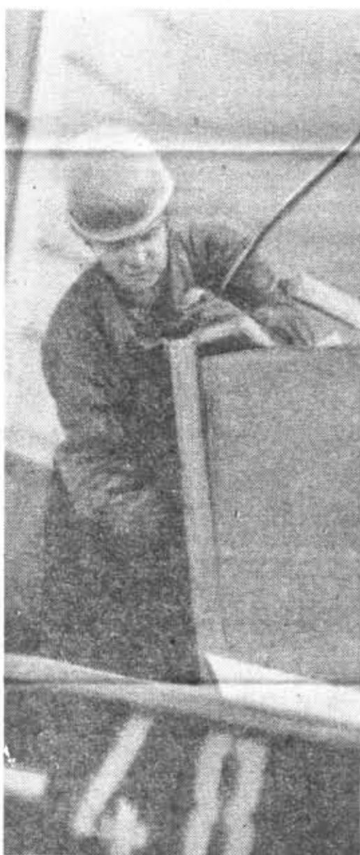
СТУДЕНТЫ И РЕКОНСТРУКЦИЯ
