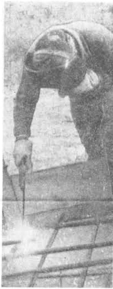
Легкий удар по стальному стержню, и вспыхивает дуга электросварки. Это Игорь Балванович из «Спар- ты» (ЛТИЦБП) работает на монтаже арматуры железобетонных конструк- ций.
