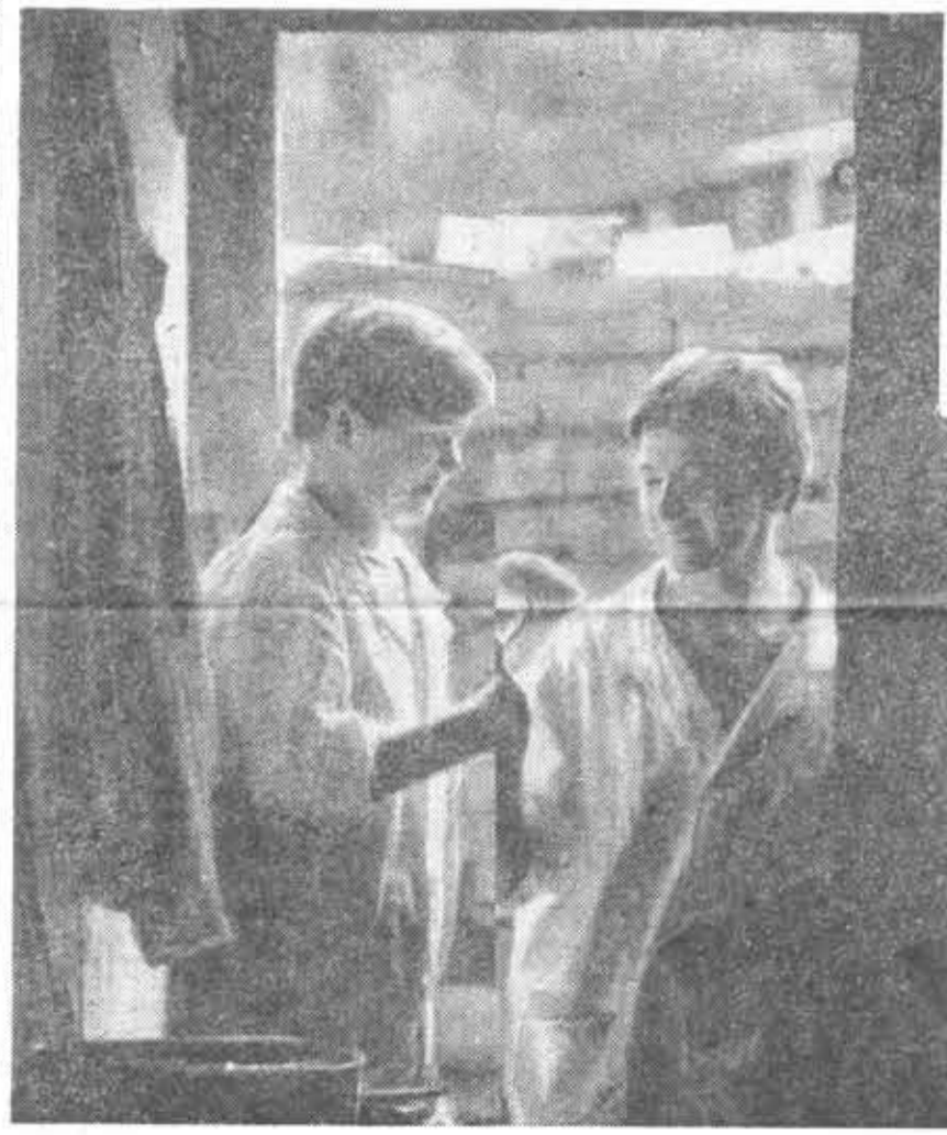
Легкий удар по стальному стержню, и вспыхивает дуга электросварки. Это Игорь Балванович из «Спар- ты» (ЛТИЦБП) работает на монтаже арматуры железобетонных конструк- ций.
