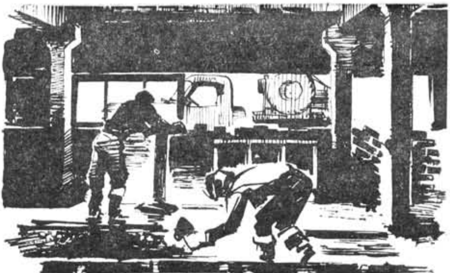
С ЭНТУЗИАЗМОМ, без перекуров работает бригада бетонщиков Саша Зеленого. Объект надо сдать в конце августа. Только бы вовремя подвезли бетон...
