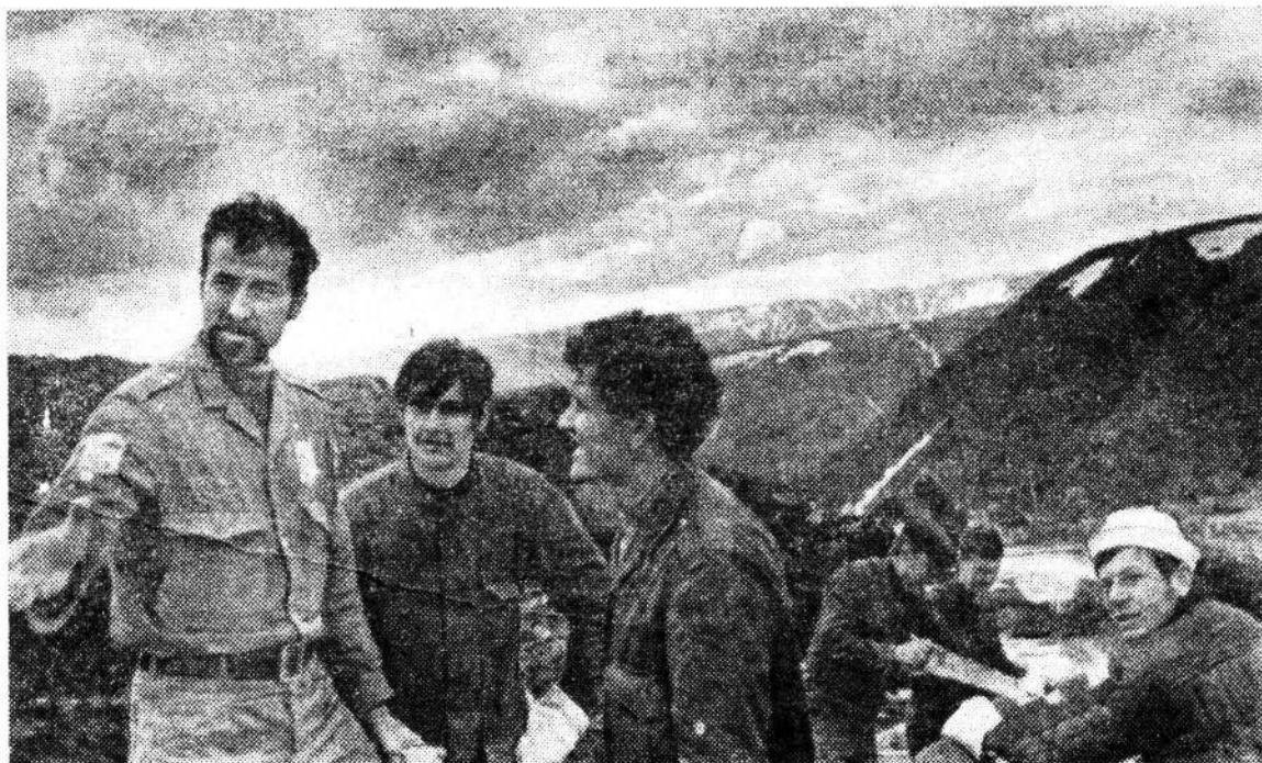
На снимке М. Мальцева: на высоте свыше тысячи метров на плато Расвумчорр студенты бетонруют кабельный мост для энергоснабжения центрального рудника комбината «Апатит». На первом плане (слева направо) командир отряда Анатолий Си-
