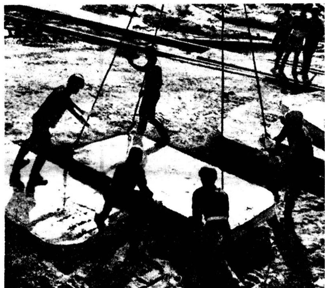
Дорога и канал обогреть. Бригада Виктора Холунова (отряд «Гелиос», ЛТИ им. Лавоцкого) приступила к укладке железобетонных плит.
