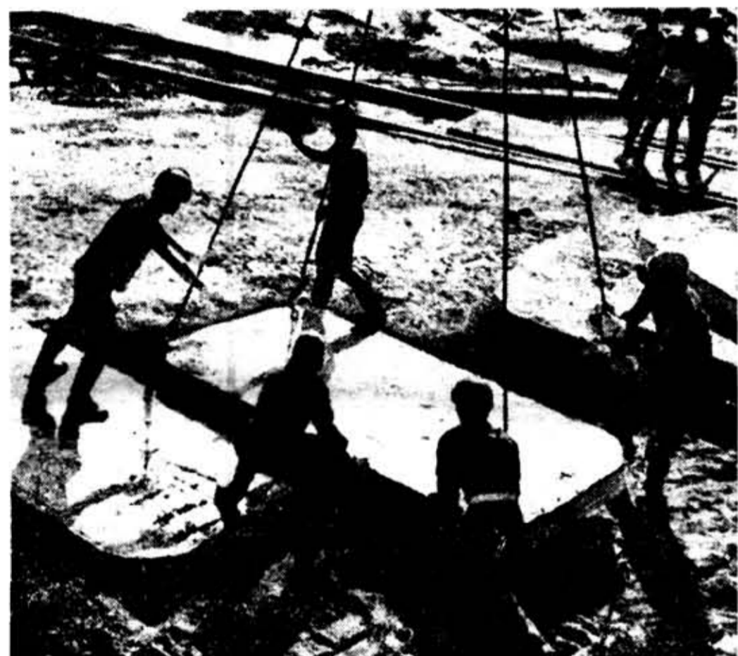
Дорога и канал обогреть. Бригада Виктора Холунова (отряд «Гелиос», ЛТИ им. Лепсовца) приступила к укладке железобетонных плит.
