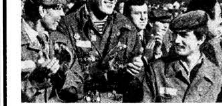
Вайнало-Амурская магистраль. Она прорвет вековую тайгу, поможет доставить несметные богатства Сибири и Дальнего Востока на службу Родине. Над строительством этой крупнейшей железной дороги взяла шефство Ленинский комсомолец. По призыву партии на трассу недавно прибыл Всесоюзный строительный отряд имени XVII съезда ВЛКСМ. Комсомольцы-строители, направлявшиеся на прокладку магистрали, посетили легендарный Братск. Они осматривали город, побывали на Братской ГЭС. На снимках: бойцы отряда имени XVII съезда ВЛКСМ.
