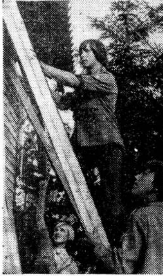
● На строительстве жилого дома работает бригада Виктора Агеева. ● Бойцы отряда «Монолит» разбирают чертёж экспериментальной сушилки. В центре — командир отряда Ю. Яковлев.
