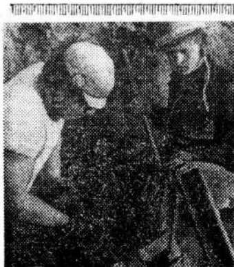
● Вахтанг Пертенава и Владимир Яковлев чинят «туфельку» — емкость для бетона.
