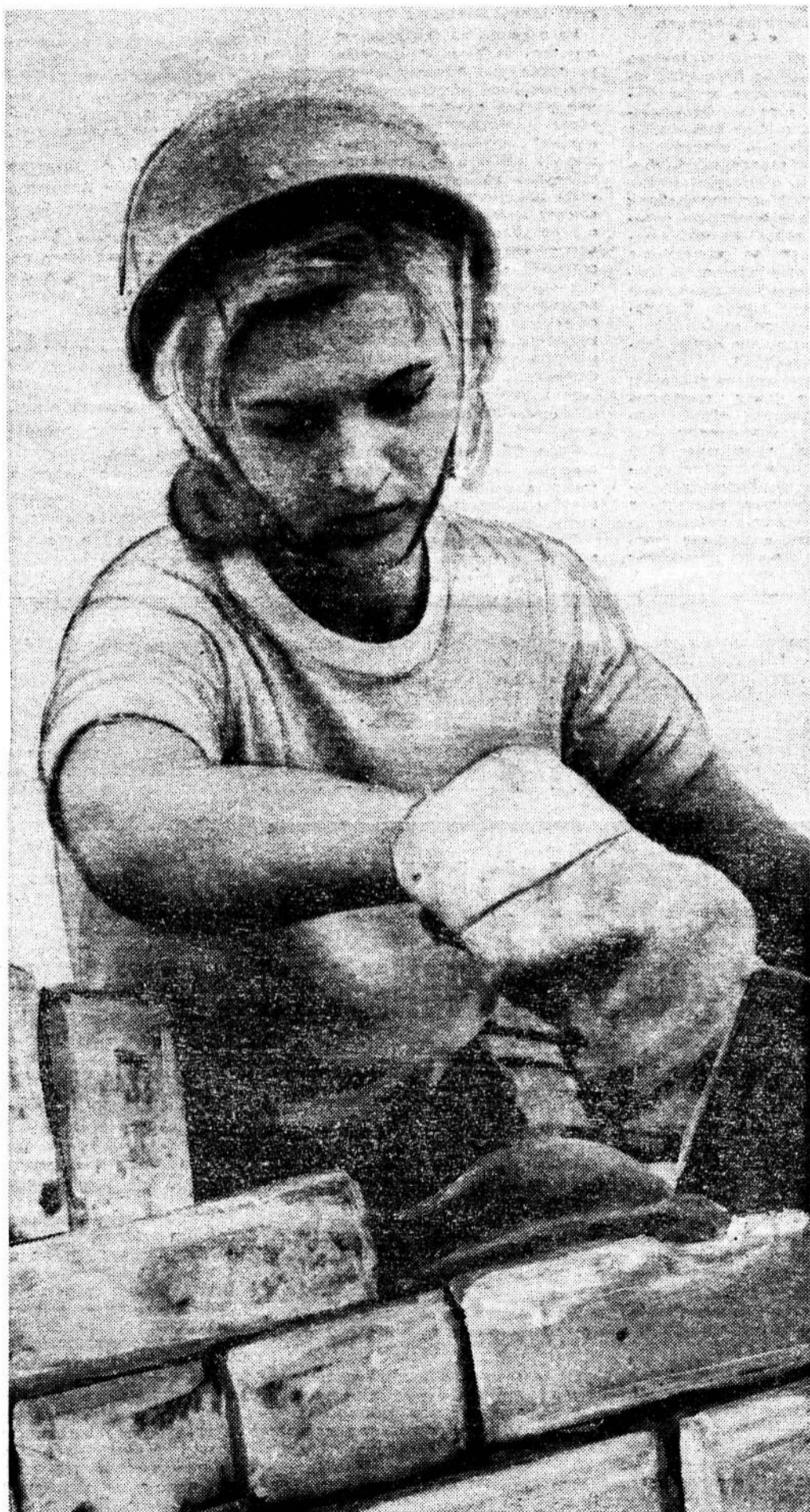
Отряд «Атлант» Ленинградского педиатрического медицинского института занят на строительстве фермы в колхозе имени Жданова Волосовского района. Успешно справляясь с новыми для них специальностями каменщиков, бетонщиков, студенты-медики освоили за июль 32 тысячи рублей капиталовложений из 50 тысяч по плану двух месяцев.
