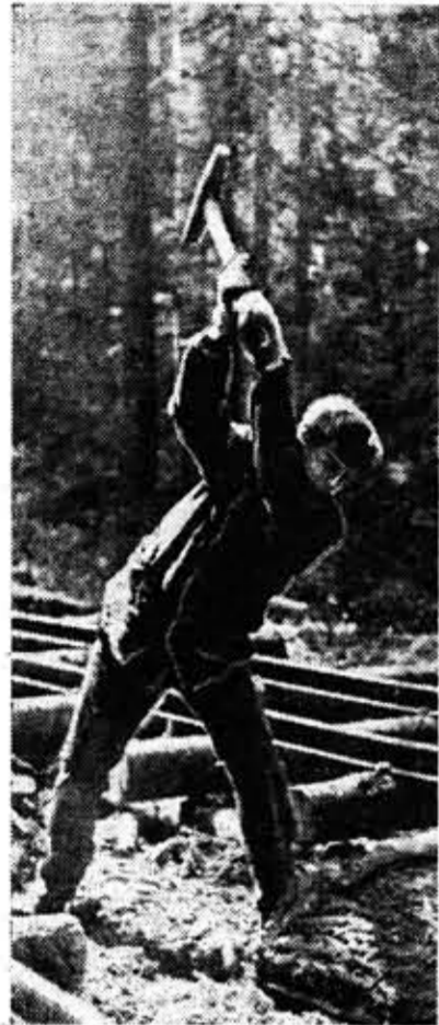
● Удар, еще один удар, и упрямый «ностыль» прочно срастил рельс со шпалой.
