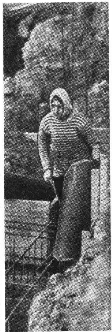
● Перед укладкой бетона.
