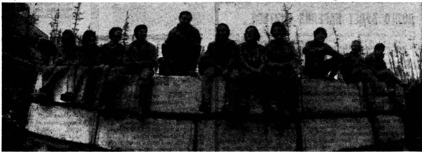
ОТРЯД ЛЕНИНГРАДЦЕВ РАБОТАЕТ НА СТРОИТЕЛЬСТВЕ МОСТА ЧЕРЕЗ ЛЕНУ.
